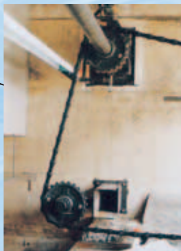
Nieuwe tandwielen gemonteerd op bestaande assen
